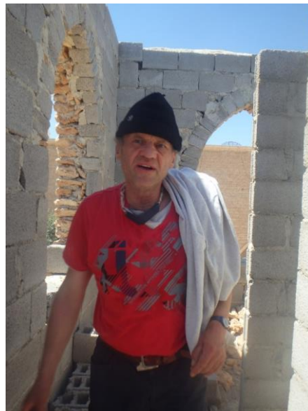
Op het kleine "metokion" (annex - mannenklooster) in aanbouw
