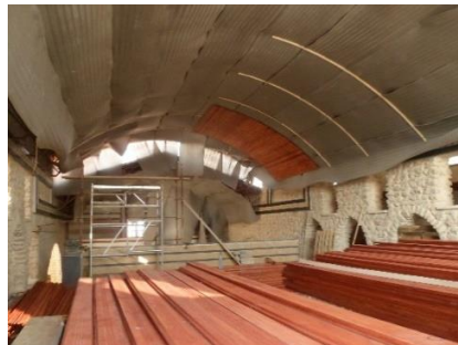
Isolatie van de nieuwbouw
