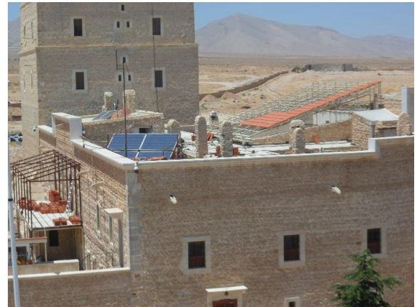
Dakpannen worden gelegd
