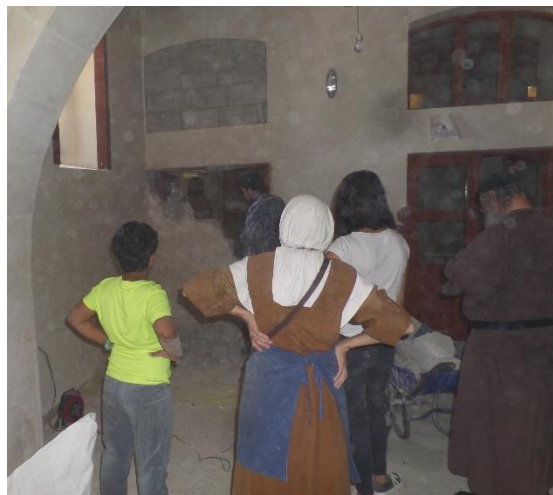
Een muur wordt verwijderd
